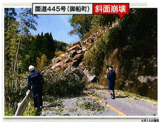
図 30 御船町の道路支障箇所
