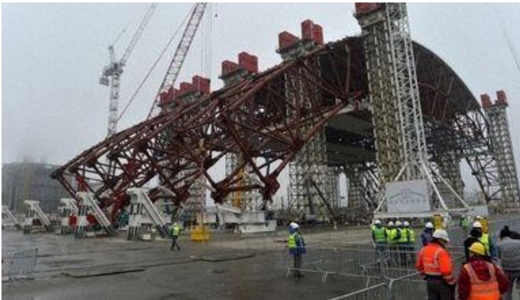
チェルノブイリ原発の石棺と建設中のアーチ上のシェルター③ (2012年11月27日撮影)
