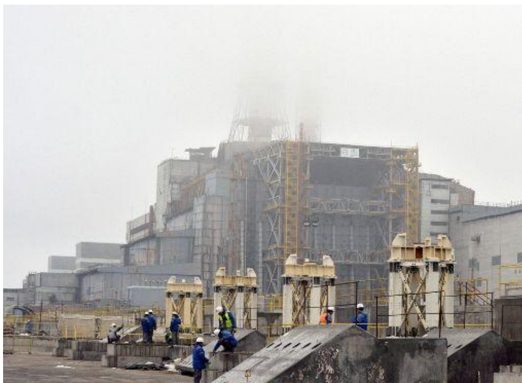
チェルノブイリ原発の石棺と建設中のアーチ上のシェルター①
