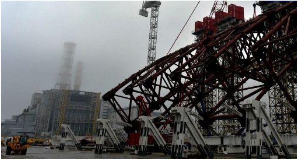
チェルノブイリ原発の石棺と建設中のアーチ上のシェルター② (2012年11月27日撮影)
